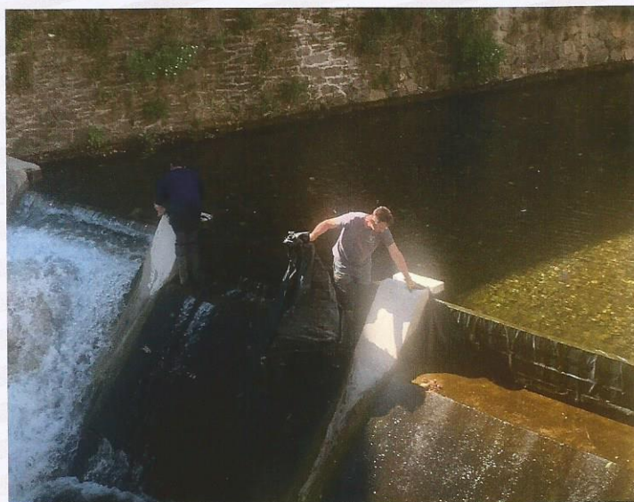
Pose du barrage
