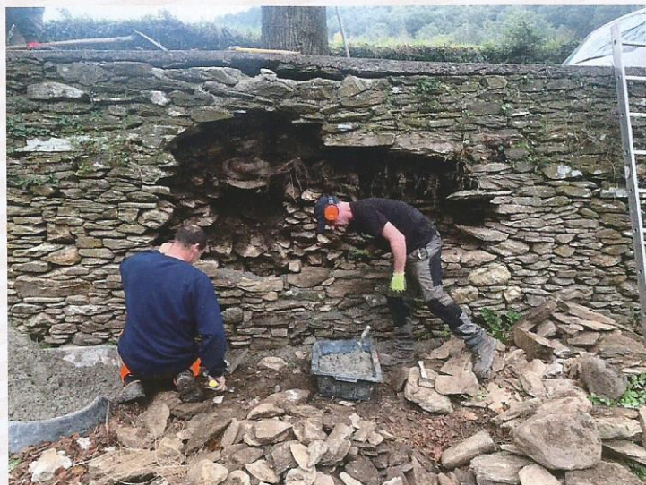
Réparation d'un mur
