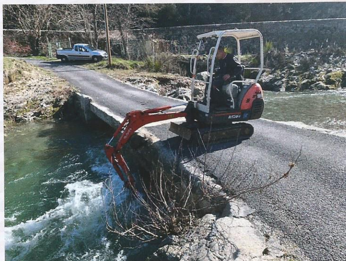
Nettoyage d'une passerelle
